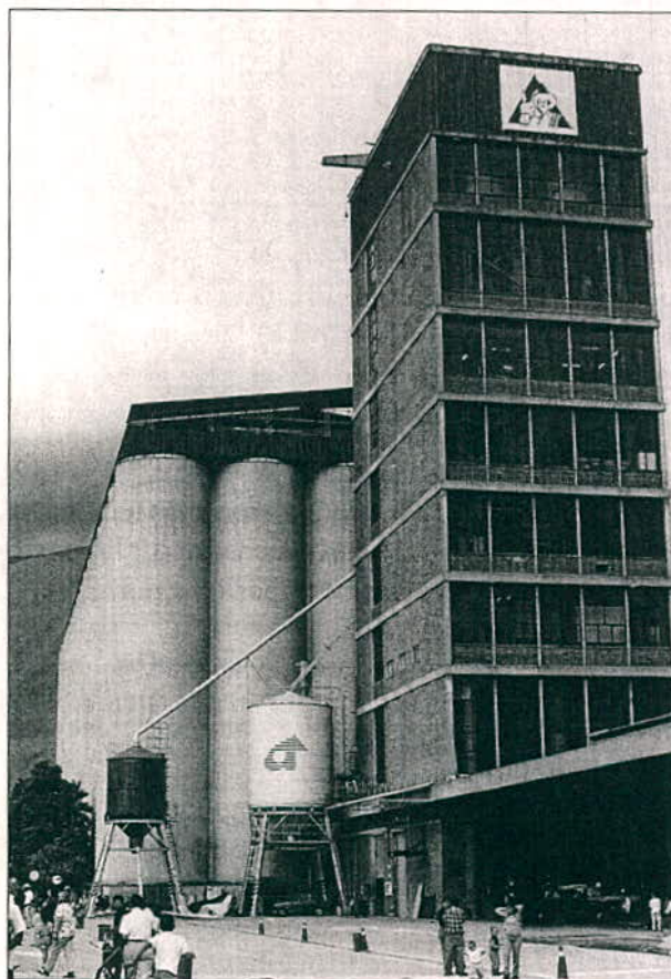
Figura 4. Batería de 60 silos de 30m de altura y 6m de diámetro, para el almacenamiento de café pergamino con aireación forzada nocturna. Foto: Cortesía Almacafé, Bello, Antioquia.
