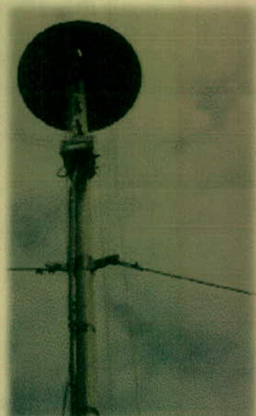
Foto No. 12 Caja del Transformador.
