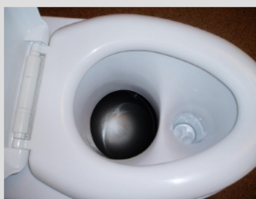
Un moderno baño sin agua, la separación ha sido desarrollado en la China-Suecia Erdos Eco-Town Project (para contacto ver tabla 2).
