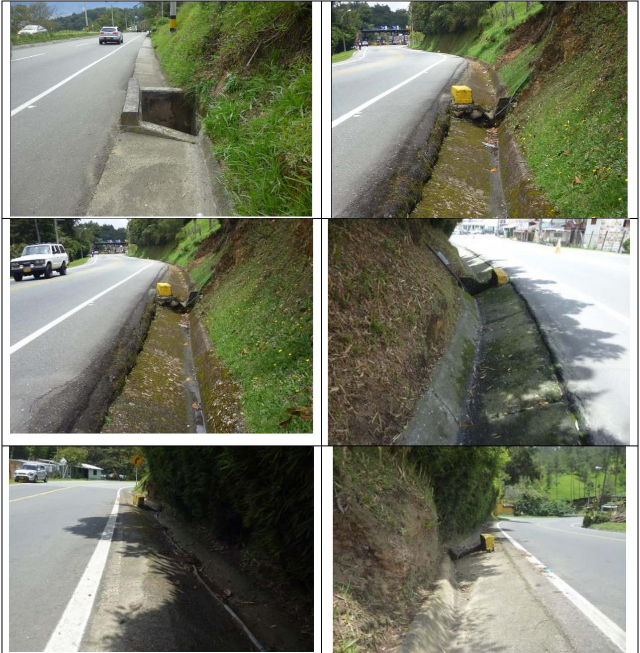
CUNETAS ACTUALES FOTO N° 1
