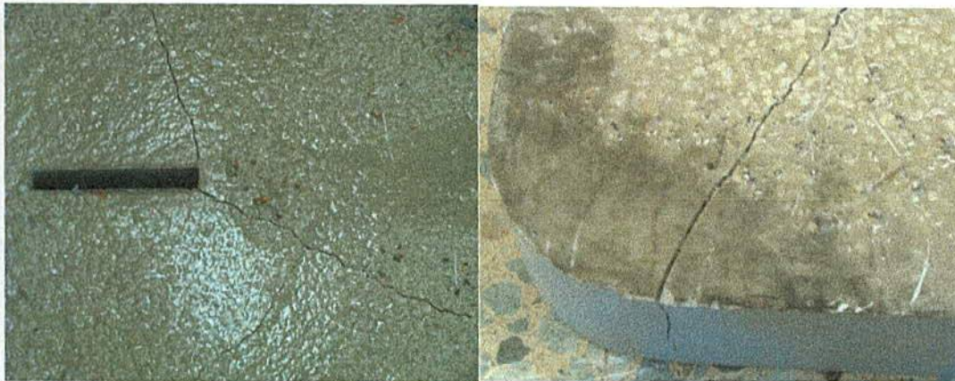
Figura 6: Fisuras y agrietamiento en el vaciado empleando la mezcla 11
