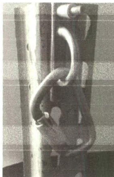
Fig 5. Imagen frontal de ubicación del conector de anclaje en el marco de la estantería
