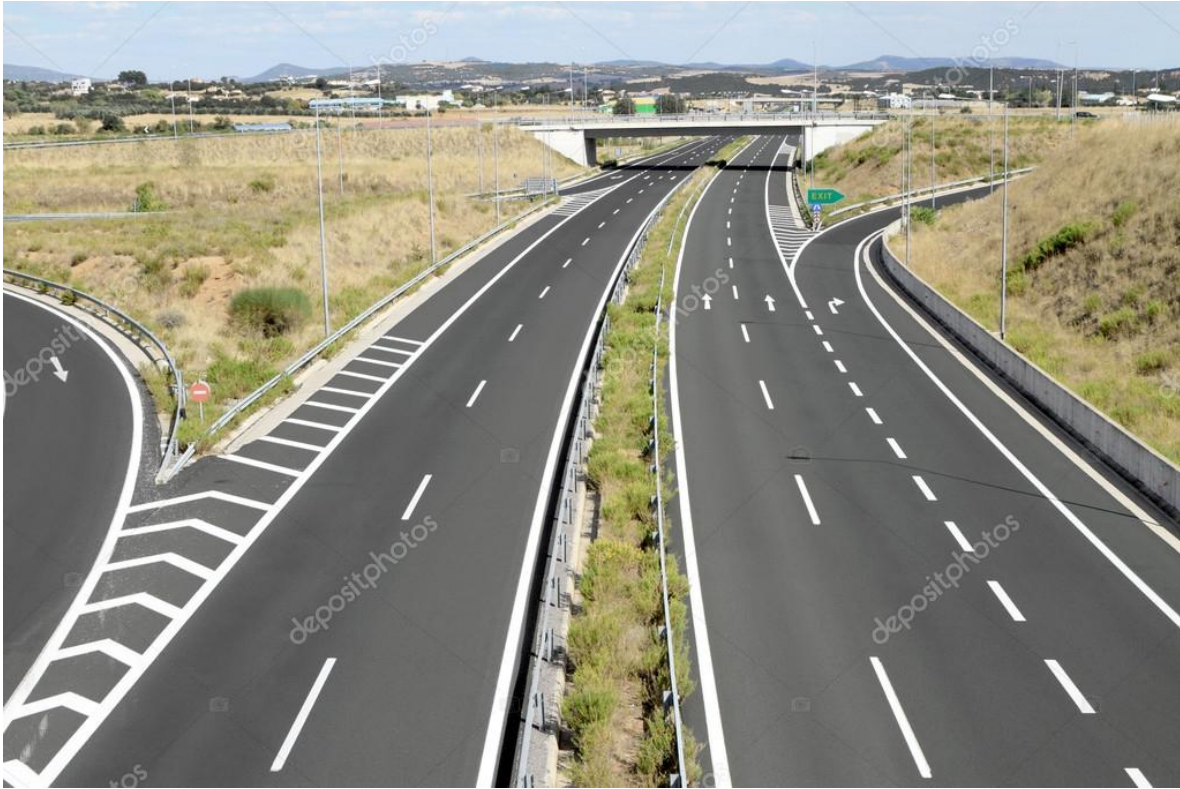
Fig 34 intercesión en autopista
