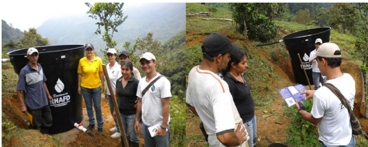
Beneficiaria Sra. Luz Denis Paloma Buitrago, Municipio de Jamundí, Vereda La Despensa, Finca El Escondite. Sistema instalado el 23 de Julio 2013
