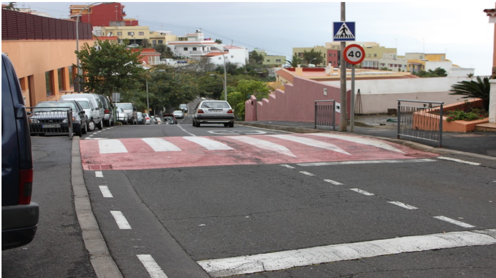
Paso peatonal y reductor de velocidad con realce
