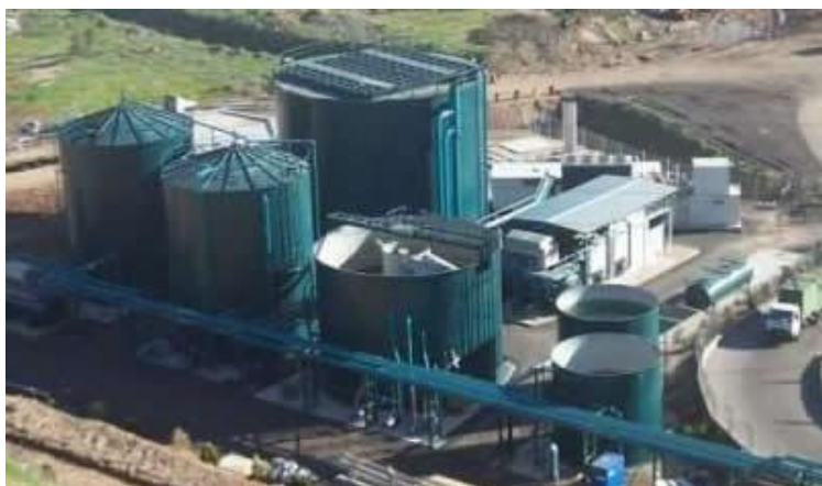
Figura 8: digestores anaerobios en construcción en Tel Aviv Israel [6]
