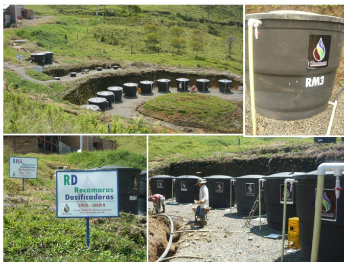
Figura N°10 Dispositivo para toma de muestra efluente, llave de paso. SMTA Jardín, Central de beneficio de café, vereda la Arboleda. Jardín - Antioquia Año 2011
