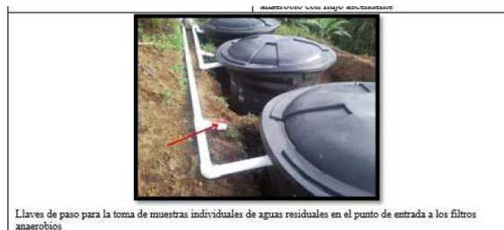
Figura N°9 Llaves de paso Documento D5 – Rendón Universidad de Manizales
