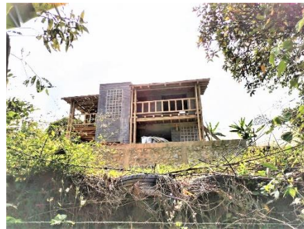
Casa de ladrillos con ceniza bagazo, vidrio y lodos PTAR de pintura y acetileno
