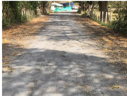
Vía ingenio para vehículos 52 ton con 96% de residuos propios (febrero 2020)
