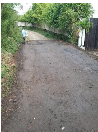
Vía rural finalizada húmeda
