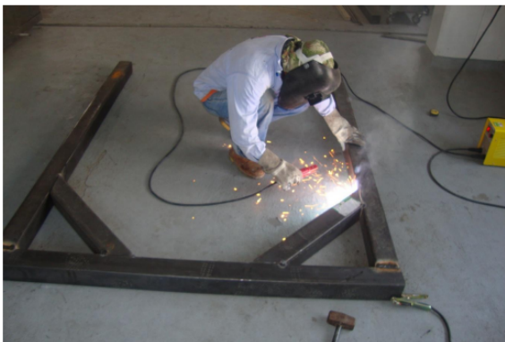
Figura 42. Construcción de torre.
