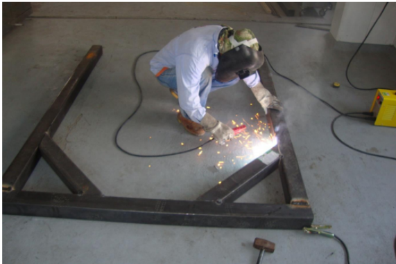
Figura 42. Construcción de torre.
