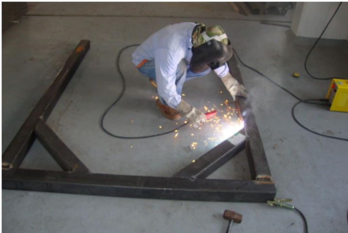
Figura 42. Construcción de torre.
