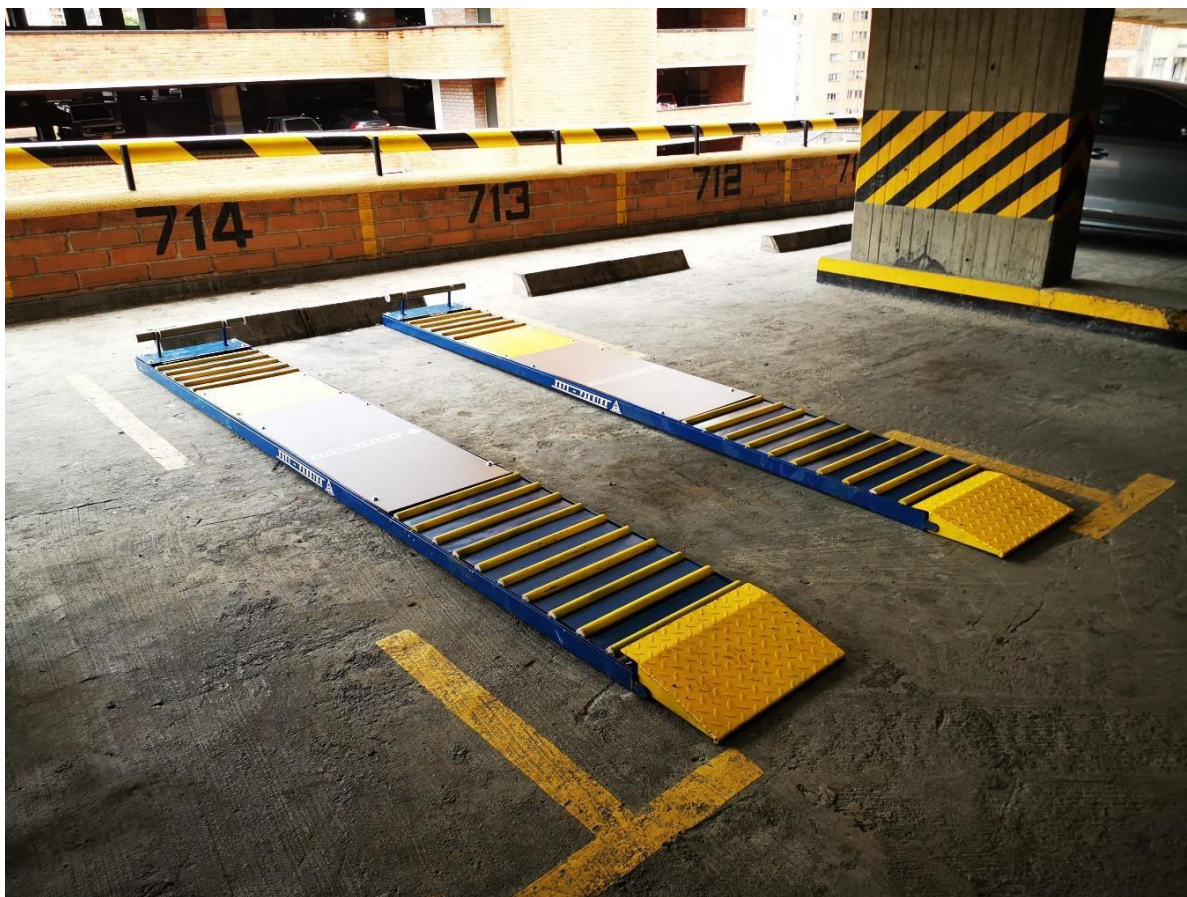
FOTO N. 5 SOLUCIÓN INSTALADA (TOPE RUEDA DE SEGURIDAD DE PARQUEO)
