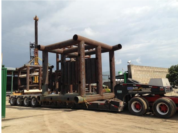
Arrecife artificial cúbico vertical
